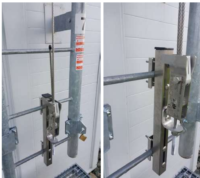
Fot. 1. VERTIGRIP. Certyfikowany pionowy system linowy dla dwóch operatorów, polecany szczególnie dla drabin bez klatki zabezpieczającej.
